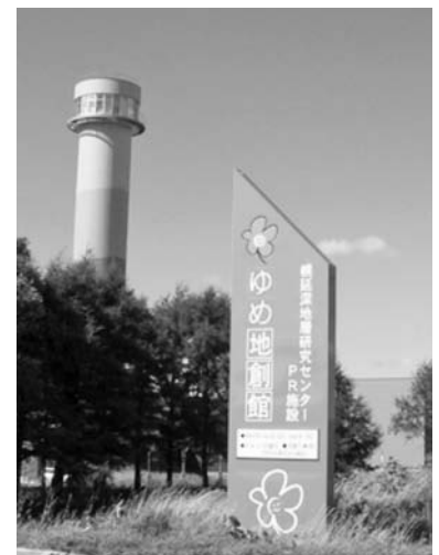
写真一 3 幌延深地層研究センター入り口
