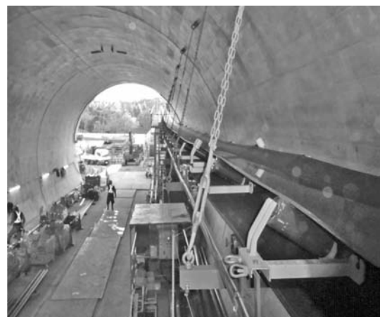
写真-3 連続ベルトコンベヤ
