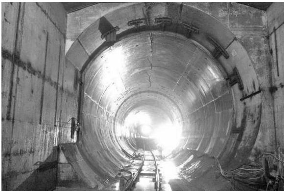
写真—6 トンネル接続部(覆工終了後)
