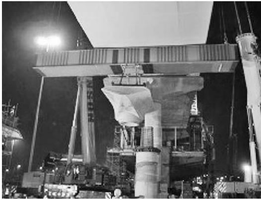
写真—8 柱頭部架設状況
