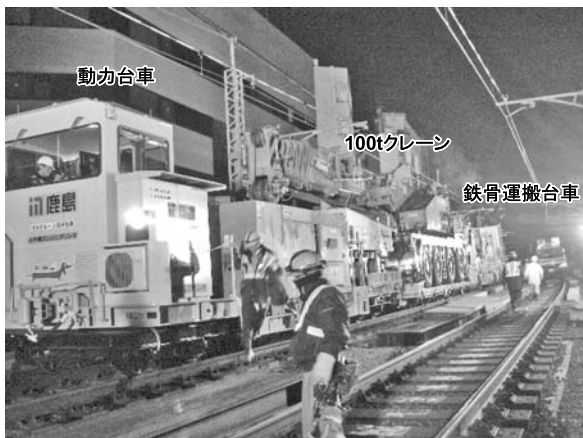
図一 7 鉄骨架設編成
