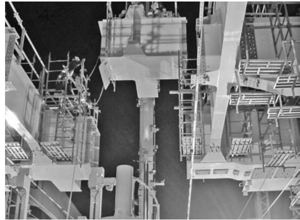
図一 9 鉄骨架設状況
