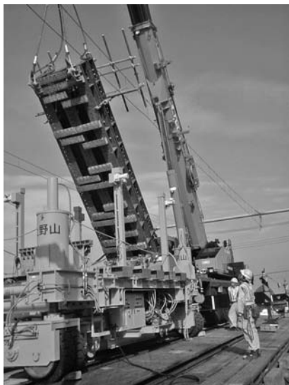
図-6 試験施工(柱吊上げ)
