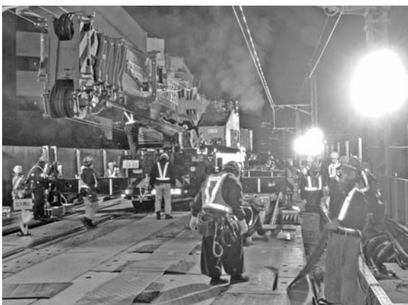
図一 8 新幹線上の覆工板上のクレーン移動
