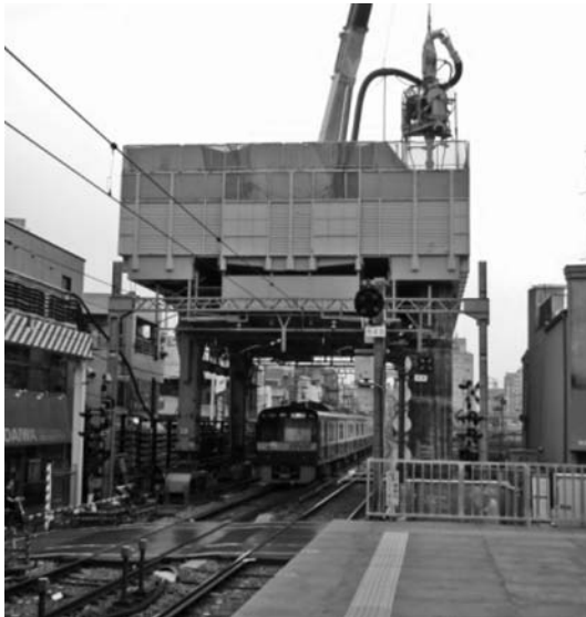
写真一 杭施工機
