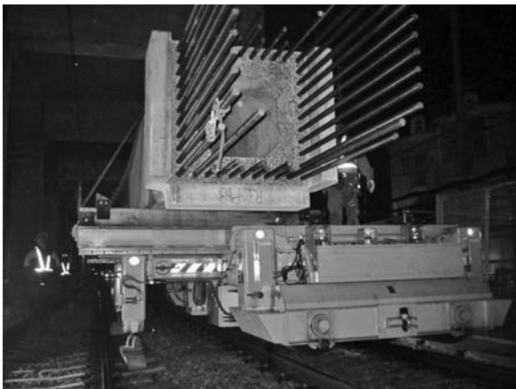
写真一六 荷台スライド機構による積み降ろし
