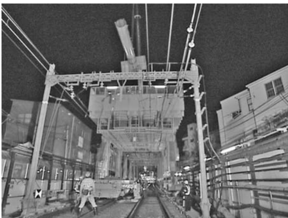
写真二 架設施工機
