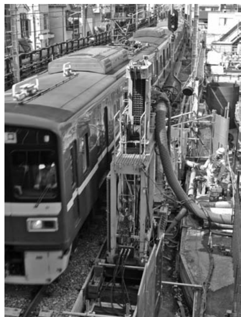
写真一 狭隘型リバース杭施工機
