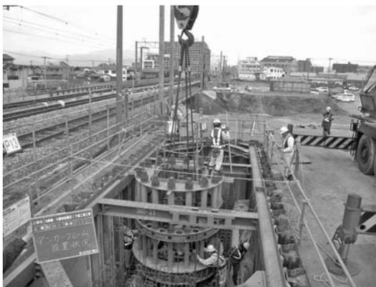
写真—4 アンカーフレーム設置状況
