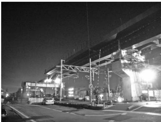
写真—11 夜間送出し施工状況
