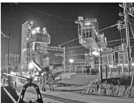
写真—9 夜間橋梁回転施工状況
