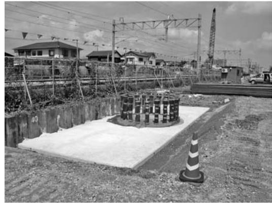
写真—5 門型橋脚基礎完了（場所打ち杭）
