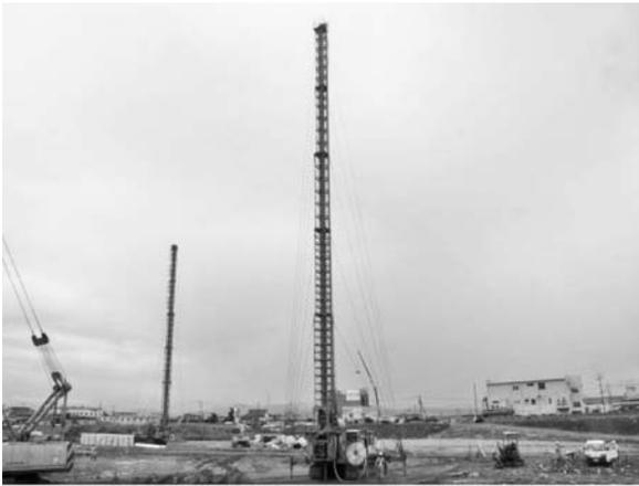
写真一 鉛直ドレーン打設状況 (機械：鉛直ドレーン打設機)
