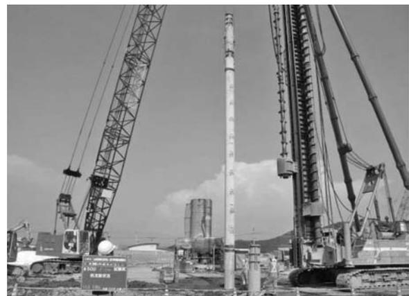
写真一 三 PHC 杭沈設状況
