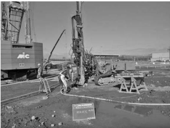
写真—4 転石チェックボーリング施工状況
