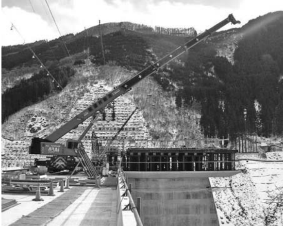
写真-3 滝沢ダム取水設備スラブ部 (吊下げ) プレキャスト施工状況
