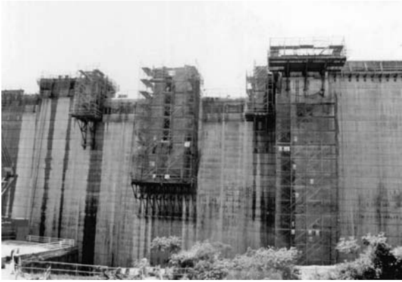
写真一 東郷ダム施工中の上流面
