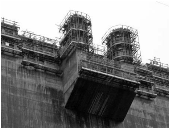
写真一七 大山ダム 常用洪水吐き上流側呑口部 プレキャスト型枠と鋼製ダム型枠
