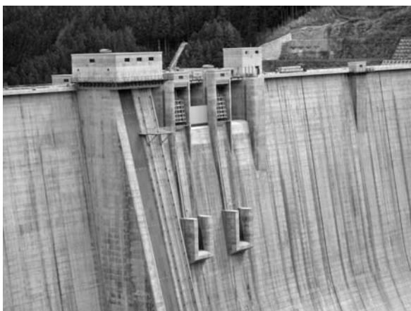
写真-4 滝沢ダムの上流面 型枠、プレキャストでいろいろ工夫製作を実施
