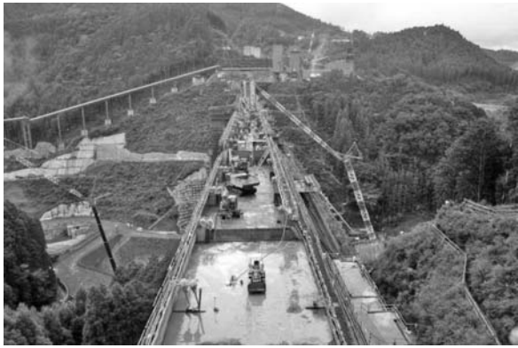
写真一五 大山ダム 右岸天端より
