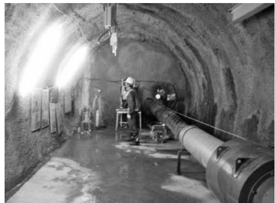
写真-14 坑内状況
