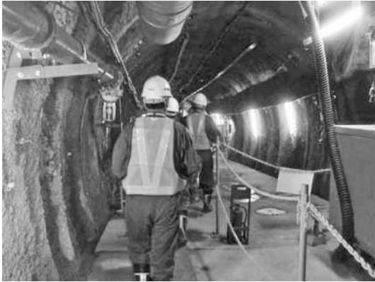
写真—15 坑内移動状況
