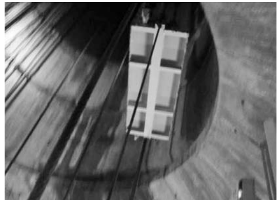
写真-12 エレベーター
