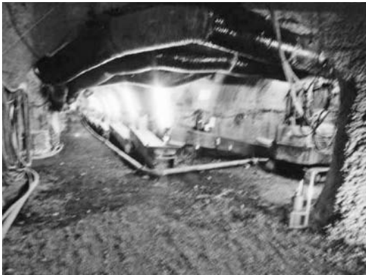
写真—16 坑道分岐部
