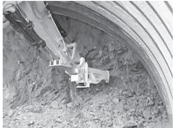
写真-3 トンネル坑口、縦型 SS-box
