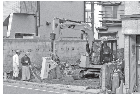
住宅隣接地での基礎解体
