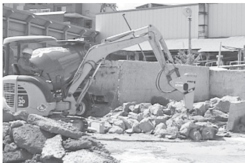
廃コンクリート解体
