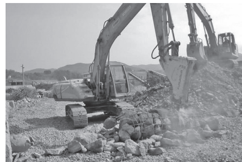
廃コンクリートガラ解体
