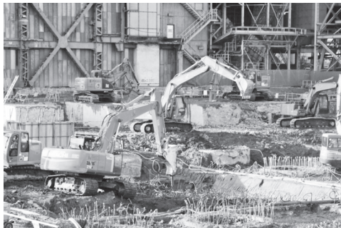
大規模設備の基礎解体
