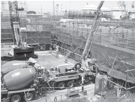
写真一七 打設状況
