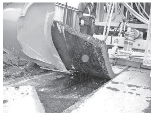
写真—6 剥ぎ取り状況
