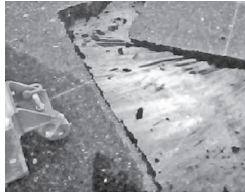
写真-7 測定箇所 (一般写真)
