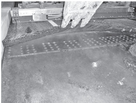
写真-10 京奈和自動車道施工
