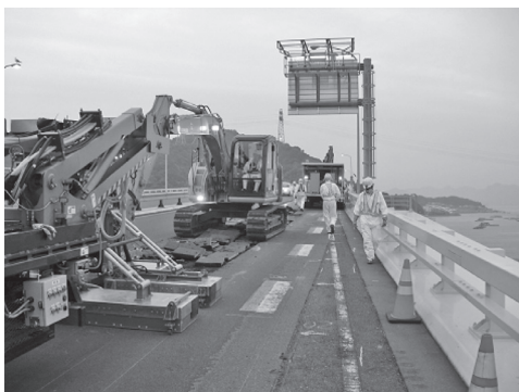
写真-11 広島呉道路/広島大橋施工
