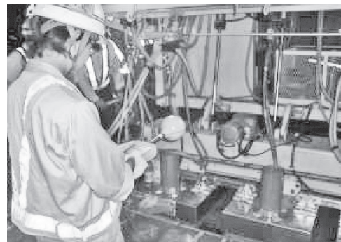
写真一 9 測定状況
