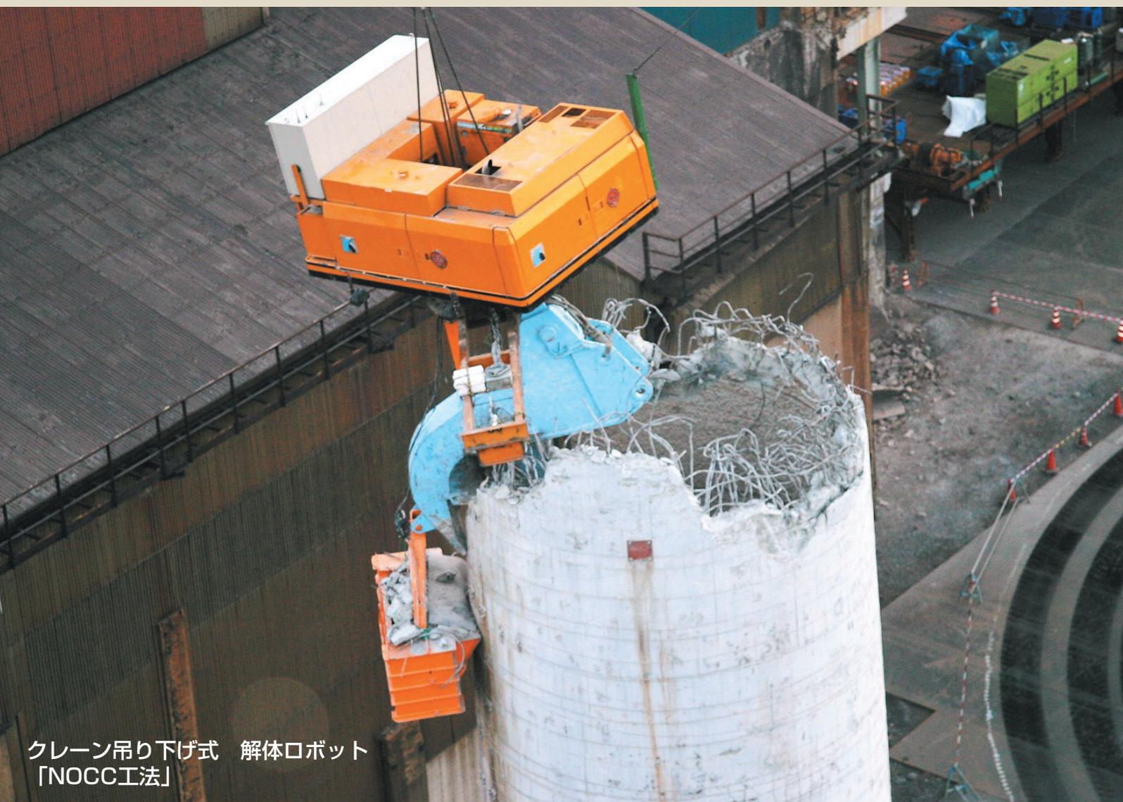
クレーン吊り下げ式 解体ロボット
