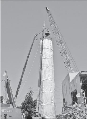
写真—6 飛散抑制シート設置状況
