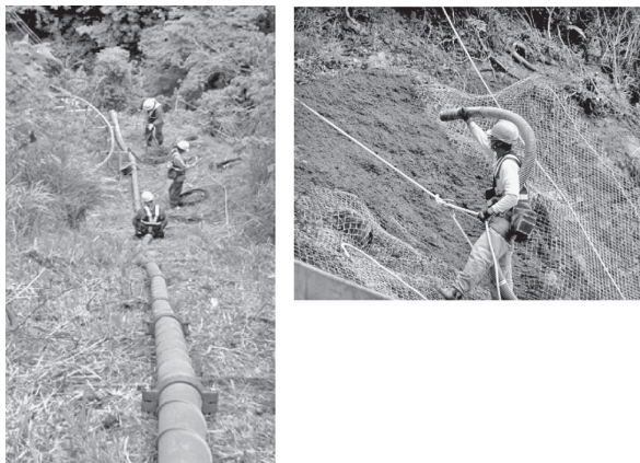
写真—6 圧送管の配管および吹付状況
