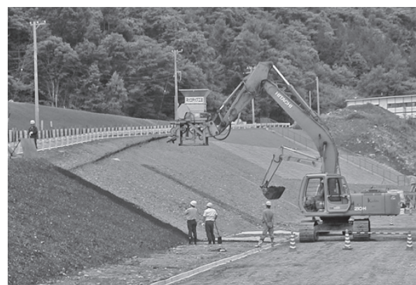
写真-4 高速ベルトコンベア方式による生育基盤の造成
