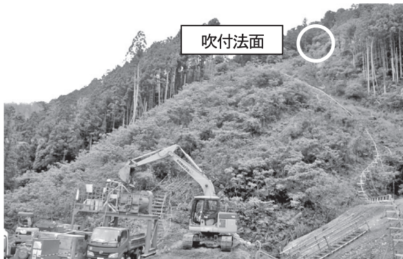
写真—5 高所施工システム施工状況（全景）
