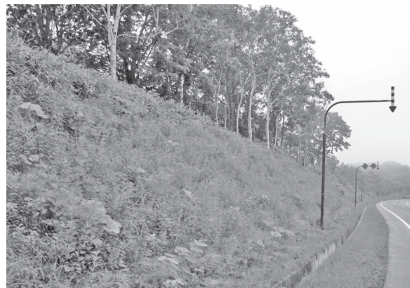
写真—7 施工後5年6ヶ月植生状況
