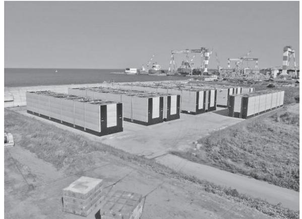
写真一3 ケーソン製作完了全景
