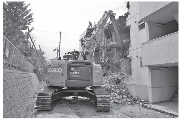
写真—8 SK235SRDLCの現場状況
