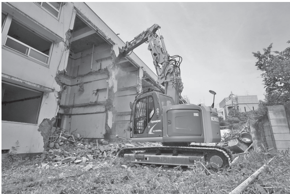
写真—7 SK235SRDLC セパレートブーム仕様機
