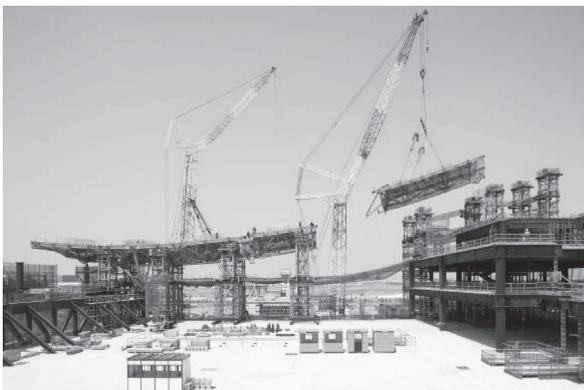
写真—7 トラス鉄骨建方
