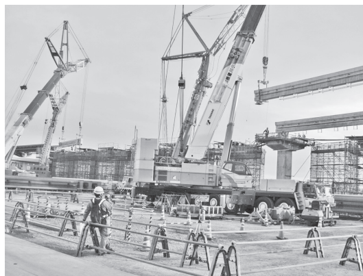
写真—2 PC 軌道桁の架設状況 (羽田空港方)
