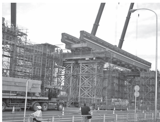
写真—3 既設合成軌道桁の撤去状況 (浜松町方)
