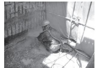
写真-11 底版部接続部ハツリ出し状況 (ウォータージェット工法)
