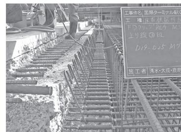
写真-16 中床版接続工 (機械式継手)
