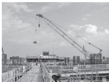
写真-14 中床版ハツリ出し状況 (ワイヤーソー切断ブロック荷揚げ)
