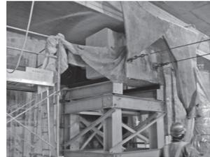
写真-22 切断ブロック引出し状況
