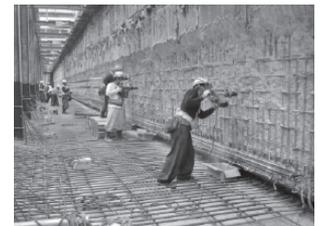
写真-13 底版部接続工 (モルタルアンカー打設状況)
