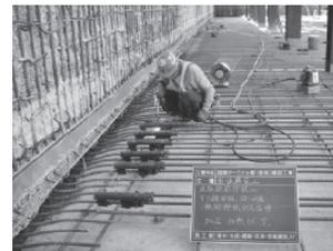
写真-12 底版部接続工 (ガス圧接状況)
