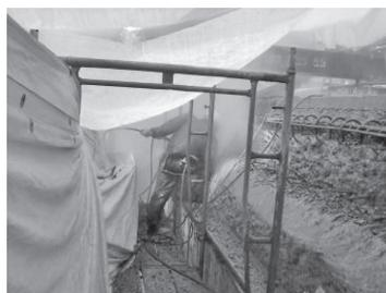
写真-15 中床版ハツリ出し状況 (ウォータージェット工法)
