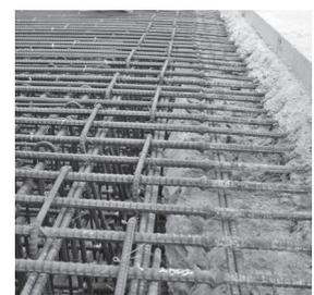
写真-17 中床版接続工 (ガス圧接継手)
