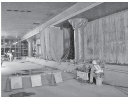
写真-21 ワイヤーソー切断状況
