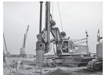
写真一五 障害物撤去（BG機掘削）
