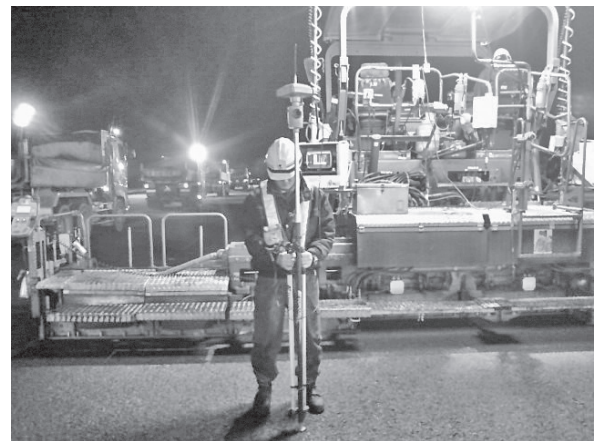
写真-2 敷き均し高さ確認状況
