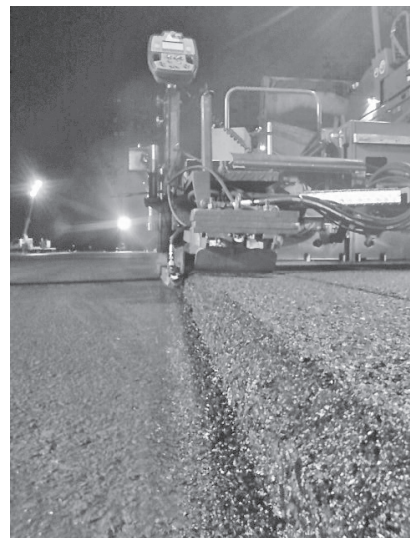
写真-6 無型枠施工装置施工状況②
