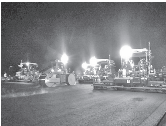
写真-1 施工状況
