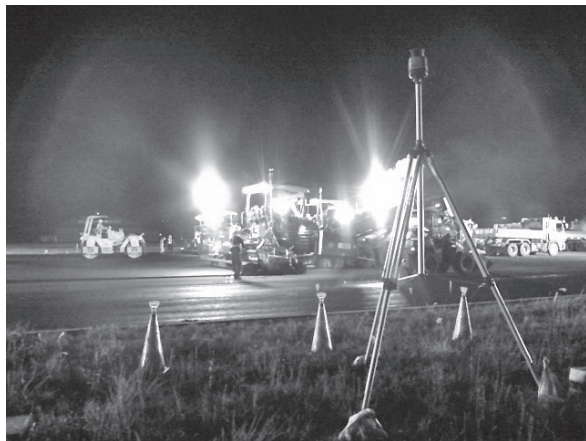
写真-4 ゾーンレーザ発光器設置状況②
