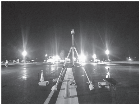
写真-3 ゾーンレーザ発光器設置状況①
