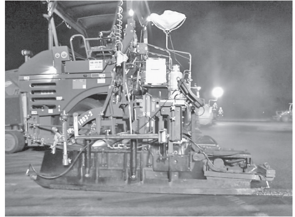
写真-5 無型枠施工装置施工状況①
