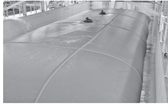
写真-11 充填が完了したジオチューブ
