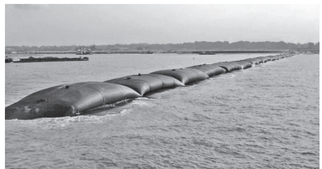
写真—1 ジオバンド施工完了時
