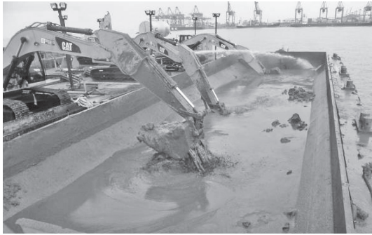
写真-9 解泥・攪拌作業
