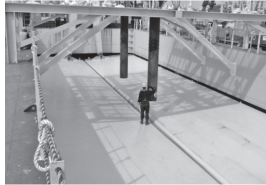
写真一2 フレームおよびシャッター
