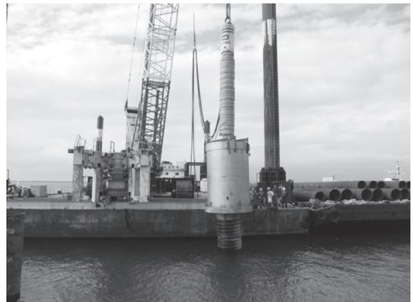
写真-1 施工状況（鋼管杭打設）
