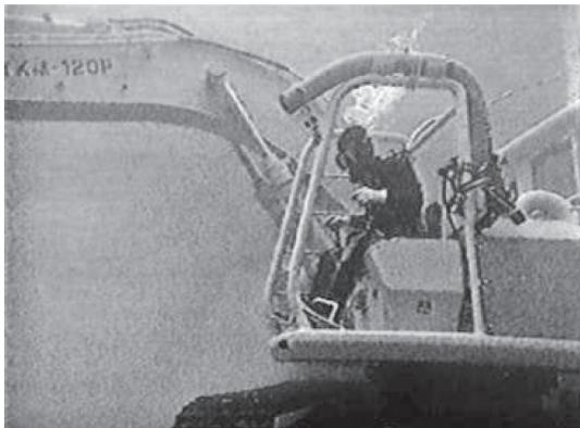
写真—2 潜水士搭乗時の施工状況
