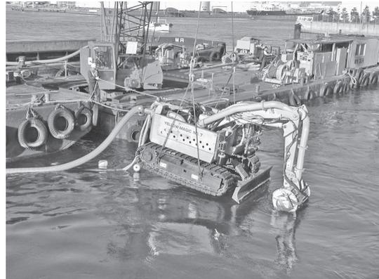
写真—5 水中バックホウ投入状況
