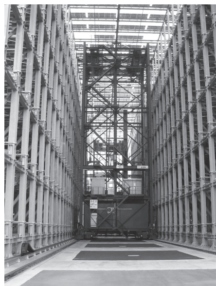
写真一 3 コンテナ立体格納庫内部
