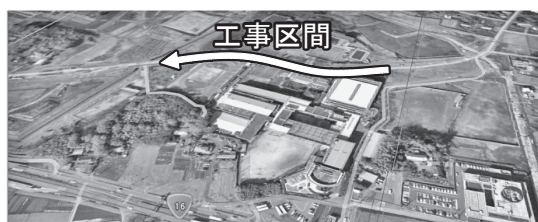
写真一1 施工場所全景
