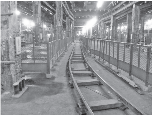
写真-5 軌条設備設置状況
