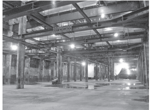
写真-6 掘削完了状況
