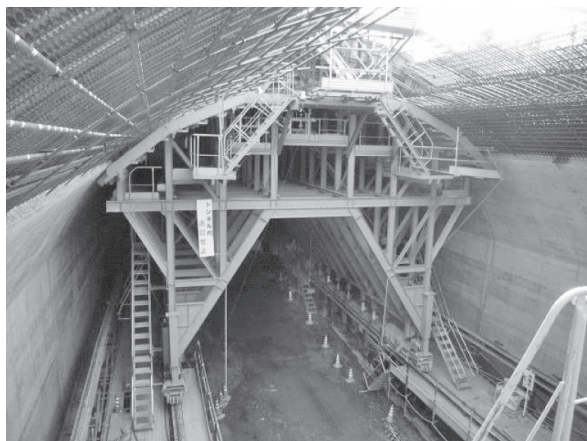
写真-3 内側アーチセントル
