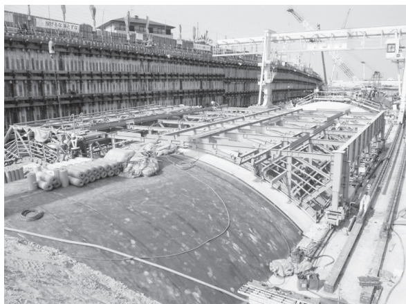
写真-4 外側アーチセントル
