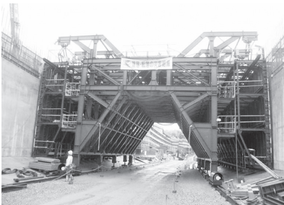
写真一8 段差部専用側壁セントル
