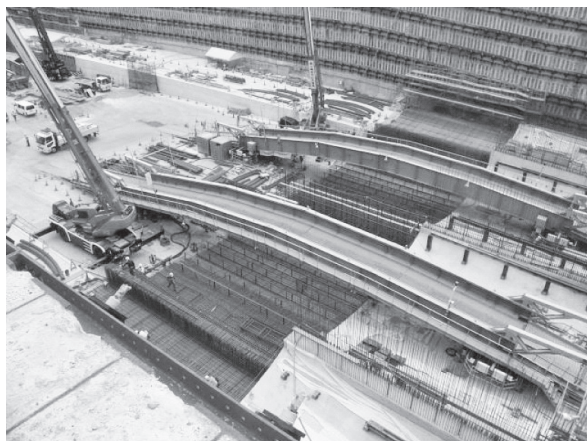
写真-5 インバート栈橋
