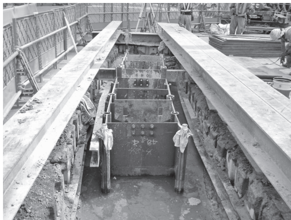
図一八 ソイルセメント鋼製地中連続壁施工状況
