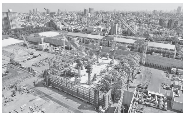
写真一2 ケーソン掘削状況
