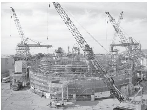
写真一三 沈下掘削状況
