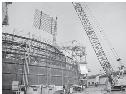
写真-2 ひび割れ制御鉄筋建込み状況
