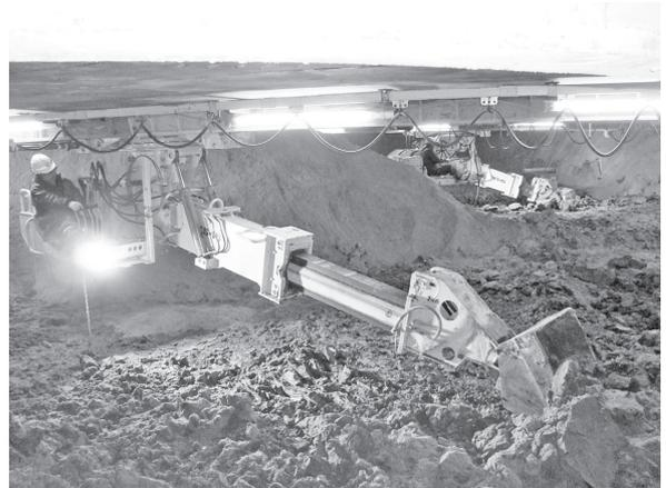
写真-8 沈下掘削状況 (有人掘削)
