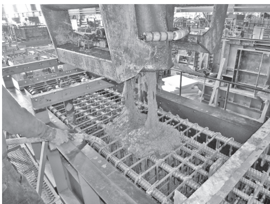
写真-4 打ち込み状況
