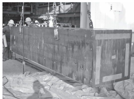
写真-6 蒸気養生槽から取り出した部材
