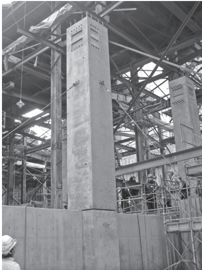
写真一七 プレキャスト柱の建て込み状況
