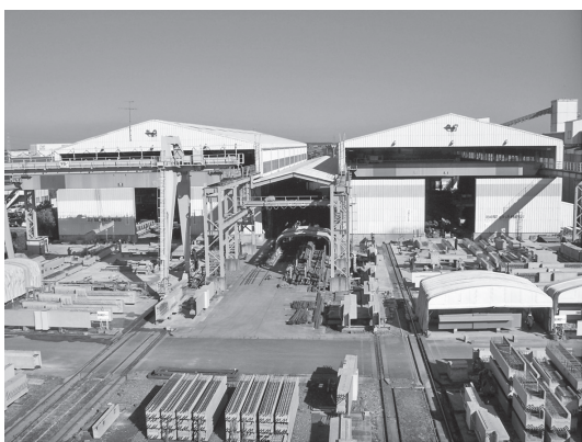
写真—2 千葉 PC 工場ストックヤード
