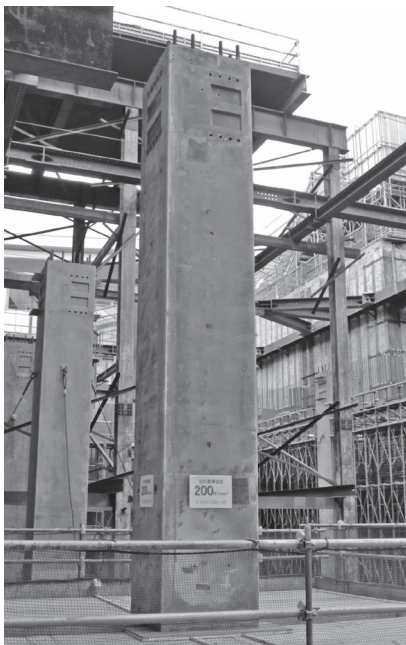
写真一八 プレキャスト柱の設置状況
