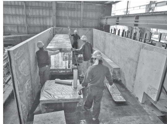
写真-5 蒸気養生槽内設置状況
