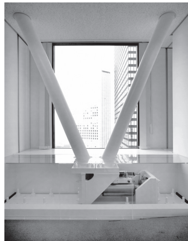
写真—4 ダンパー設置状況
