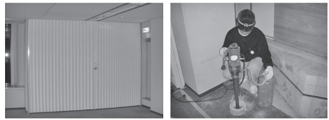
①施工時の仮囲い
