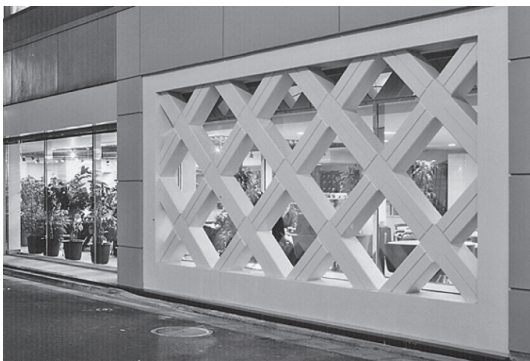
図—3 耐震補強の例
