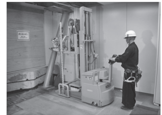
⑥ブレースの設置
