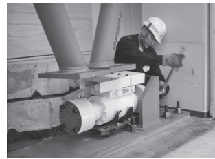
⑦制振ダンパーの設置
