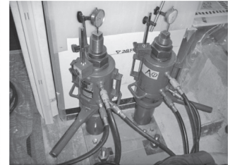
④ PC 鋼棒に緊張力導入
