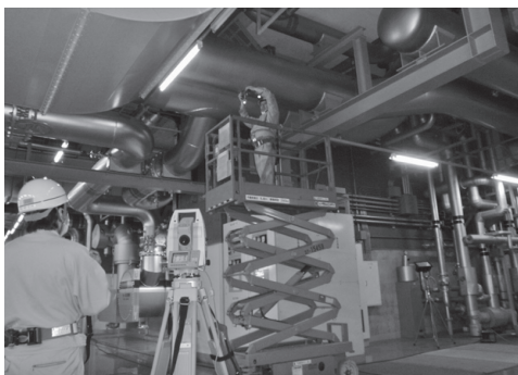
写真-1 計測の様子（プリズムを用いた計測）
