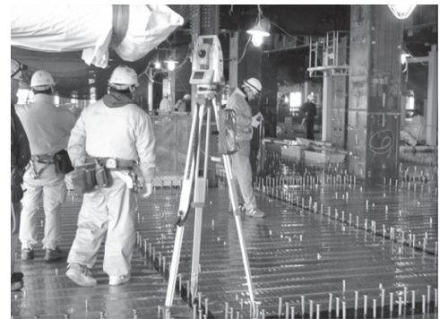
写真-3 墨出しの様子
