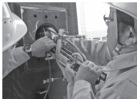
写真-5 圧入口への計測・カメラユニットの取り付け
