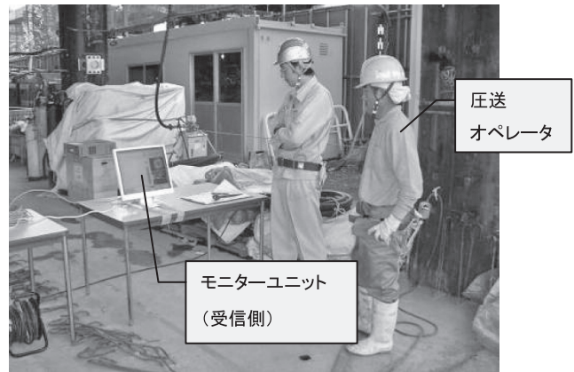
写真一4 モニターユニット設置状況
