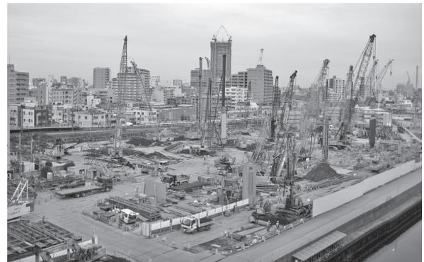
写真-6 地中連続壁杭工事状況
