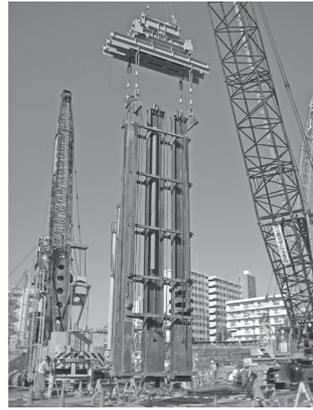
写真-4 高精度建込み治具
