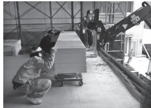
写真-8 施工階荷降作業
