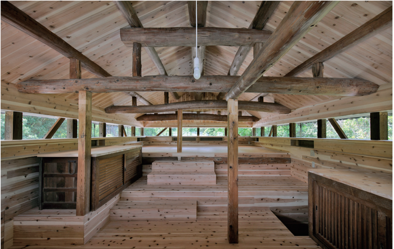
写真一七 小屋組み現しの2階寝室
