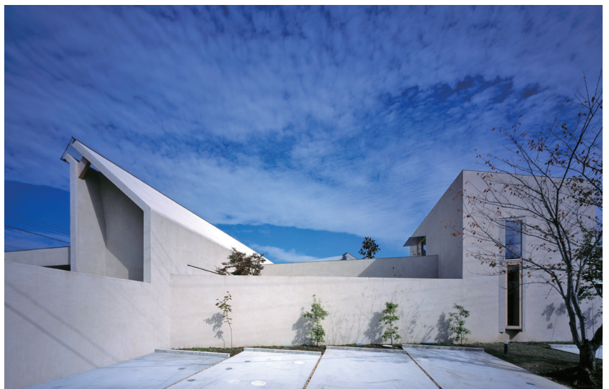
写真-4 南側から見る。
