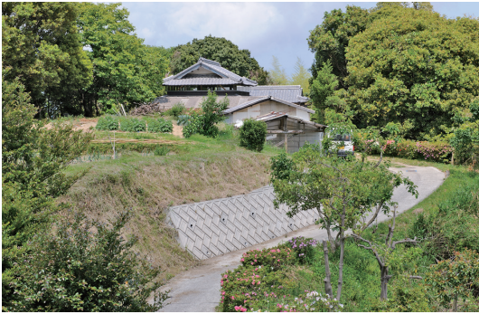
写真一五 南西側遠景。外観はほとんど変化していないように見える。敷地は防風林に囲まれた尾根部分に位置している。手前の蛇行した道からアプローチする。
