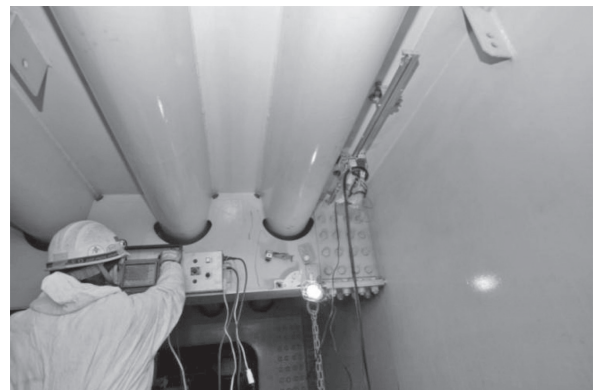
写真一 3 鋼床版での超音波探傷の状況
