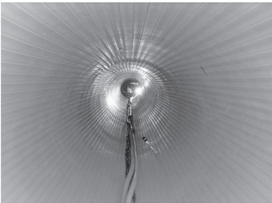
写真—11 トンネル内巻補強工完了
