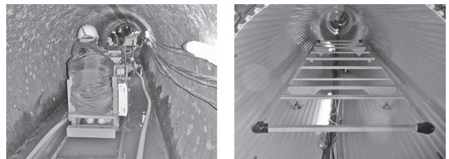
写真—6 坑内運搬設備
