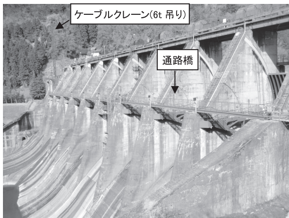
写真—2 通路橋設置状況（神二ダム）
