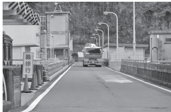
写真—3 ダム天端道路
