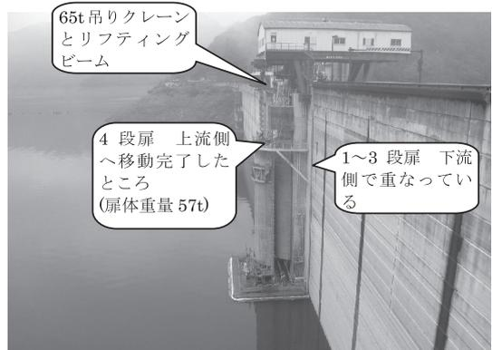
写真-4 65t吊りクレーンにより扉体を上流側へ移動 (右岸側から遠景で見る)
