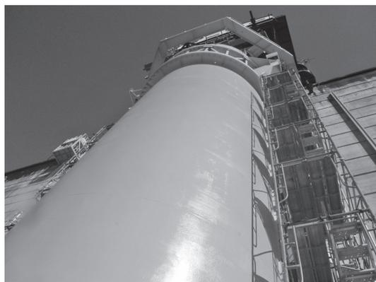
写真-12 扉体 塗替塗装 施工後近景
