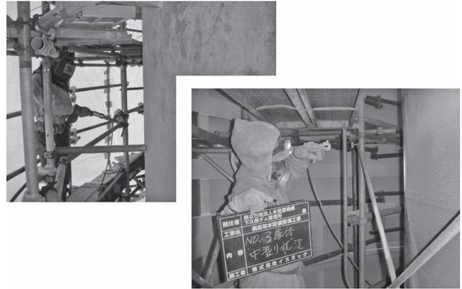
写真一九 プラスト・塗替塗装
