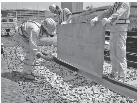
写真一2 人力による塗布施工例
