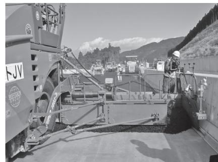
写真—3 橋梁舗装施工状況
