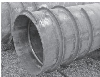
写真—1 鋼管杭先端
