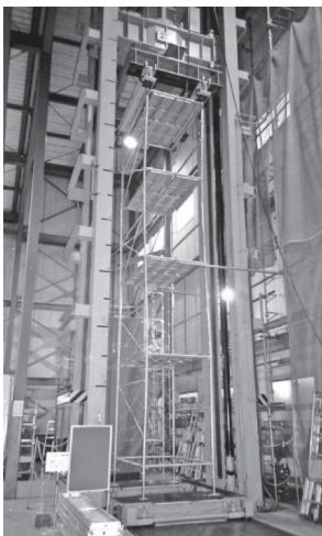
写真一 3 4層1スパン足場実大試験
