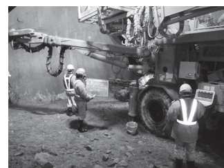
写真一13 前方探査ボーリング
