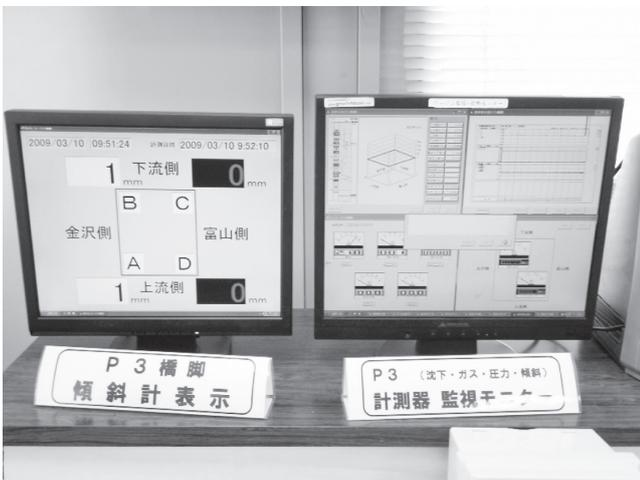
写真—10 自動沈下管理システムモニター
