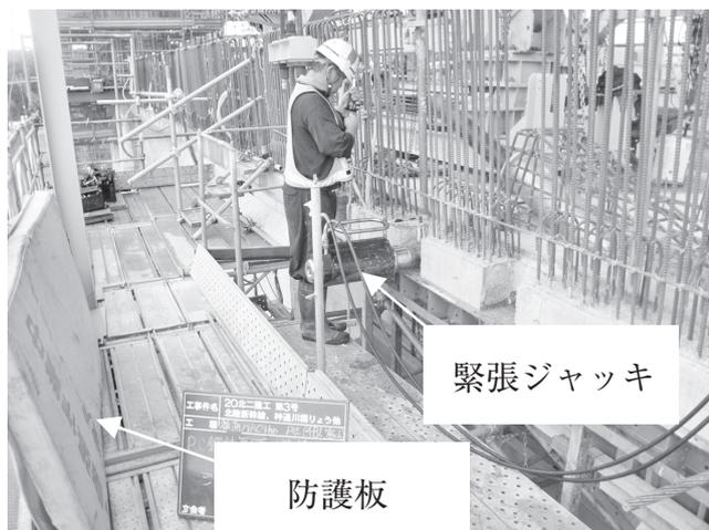
写真—14 緊張ジャッキセット状況
