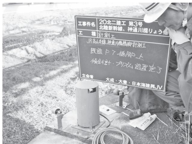
写真-5 プリズム・傾斜計設置状況
