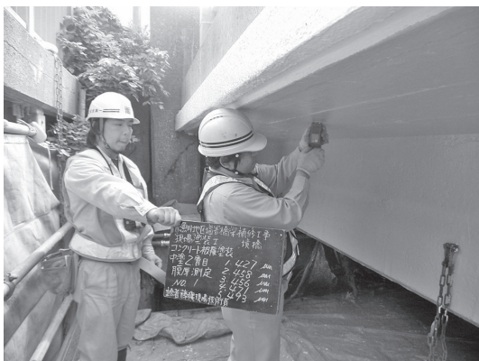
写真一3 境橋 現場塗装工段階確認
