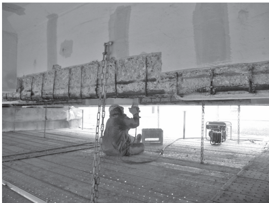
写真一2 境橋 上部工はつり作業
