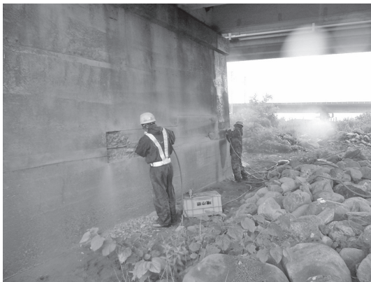
写真一1 境橋 下部工はつり作業
